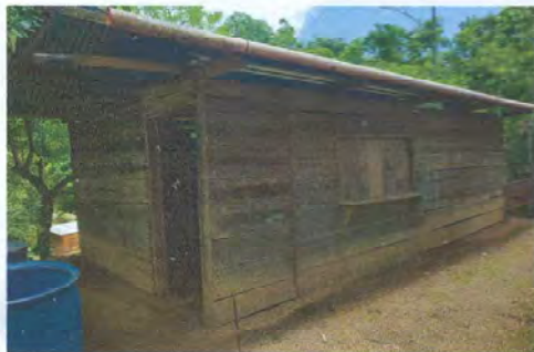
Foto 1: REPARACIÓN O SUSTITUCIÓN DE ÁREA DE COCINA
