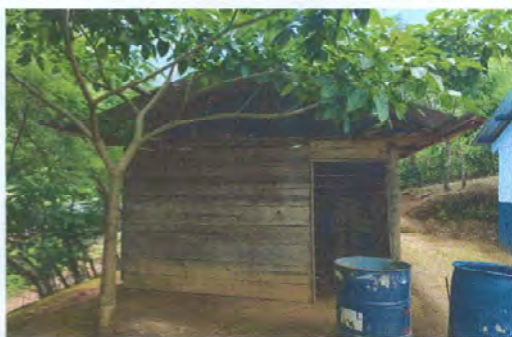
Foto 3: CANALES Y BAJADAS DE AGUA PLUVIAL
