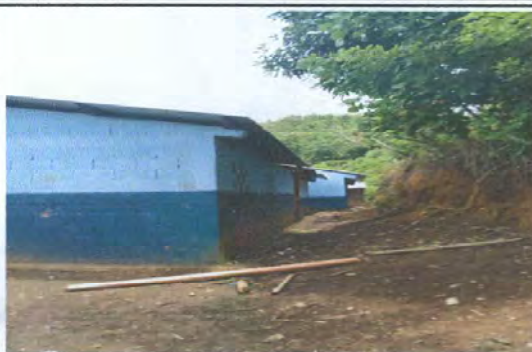
Foto1: CANALES Y BAJADAS DE AGUA PLUVIAL
