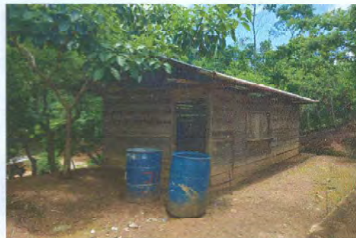
Foto 2: REPARACIÓN O SUSTITUCIÓN DE ÁREA DE COCINA
