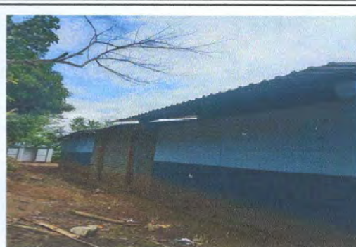
Foto 2: CANALES Y BAJADAS DE AGUA PLUVIAL
